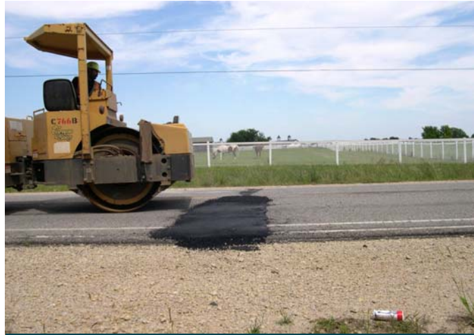
Rolling asphalt crack fill
